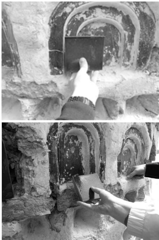
Рис. 7. Подбор оттенков муравления с представителем органа охраны (Н. Ворониной) для восстановления колористики утраченных элементов. (Фото автора).
