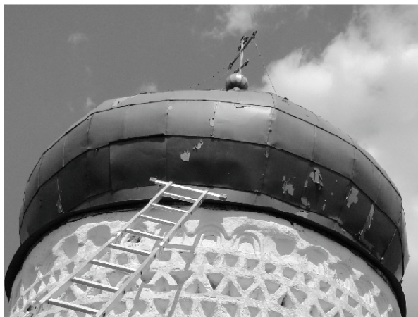
Рис. 2. Фото барабана 2014г. Видна обширная цементная вставка (слева), состояние декора и его утраты верхней части барабана. (Фото автора).
